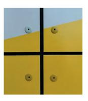
Je nach Anwendung und brandschutztechnischer Anforderung ist die Fassadenplatte in Ausführung A2 NICHT BRENNBAR oder B1 SCHWER ENTFLAMMBAR erhältlich. Bei beiden Systemen handelt es sich um eine stabile Alu-Verbundplatte mit UV-beständigem Decklack.
